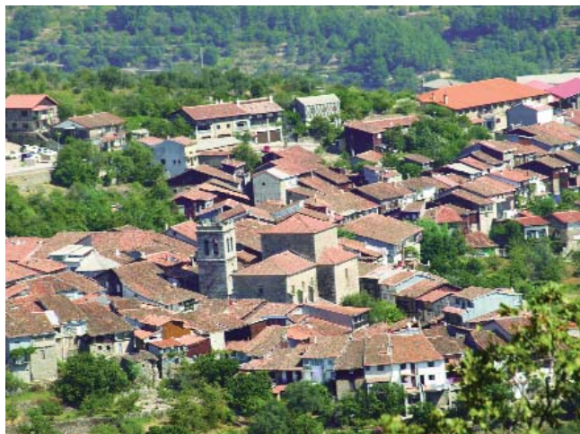
Tejados de la Iglesia de Mogarraz, desde Monforte.
