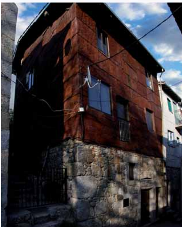
Diversas fachadas de viviendas de Mogarraz con revestimientos de chapas de latones, que han desaparecido en los últimos años: 1, calle del Hospital; 2, traseras; 3, calle Castillo y 5, calle Miguel Angel Maillo.
