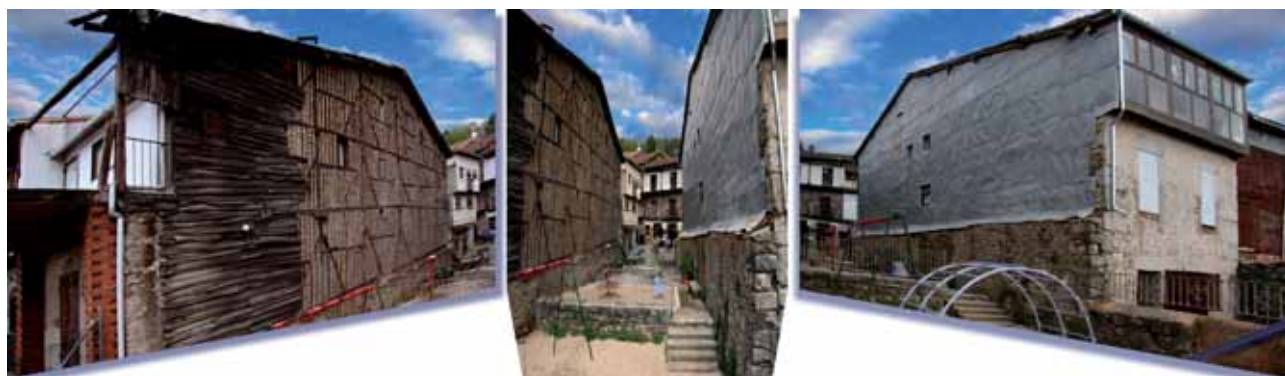
Solar de una vivienda desaparecida dedicada en la actualidad a parque infantil, ubicada en La Plazuela, Mogarraz. Característica disposición longitudinal de la planta, dejando al descubierto las medianías de las viviendas colindantes. La vivienda de la derecha está orientada al Suroeste, por donde embisten los temporales invernales, de ahí la necesidad de su protección, realizada con grandes chapas de zinc.
