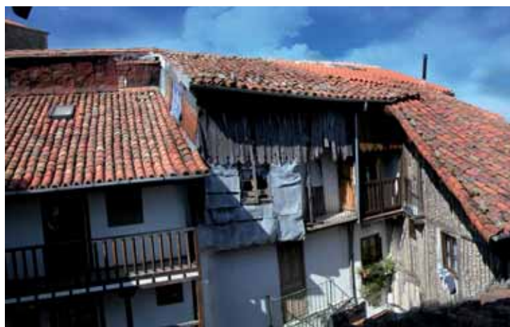
Fachada de una vivienda con protección mixta: en la parte alta, entablado vertical tradicional conservado en su estado original; seguido de una protección con chapa de zinc. Plaza del Barrio Hondo, Mogarraz.
