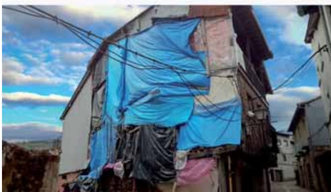
Diversos materiales usados como revestimientos de fachadas: 1, chapa galvanizada; 2, uralita plana y ondulada; 3, chapa nervada de acero galvanizado lacada y uralita ondulada; 4, lonas y plásticos clavados, chapas de zinc y pliegos de uralita ondulada.
