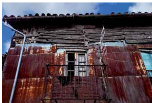
Diversas fachadas de viviendas de Mogarraz con revestimientos de chapas de latones, que han desaparecido en los últimos años: 1, calle del Hospital; 2, traseras; 3, calle Castillo y 5, calle Miguel Angel Maillo.
