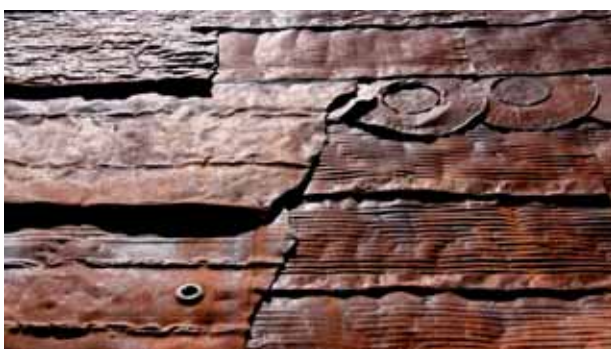
Individuo reciclando bidones, Nairobi, Kenia. Abajo, fragmento de fachada cubierta con chapas de bidones. Calle Tentenecio, Mogarraz.
