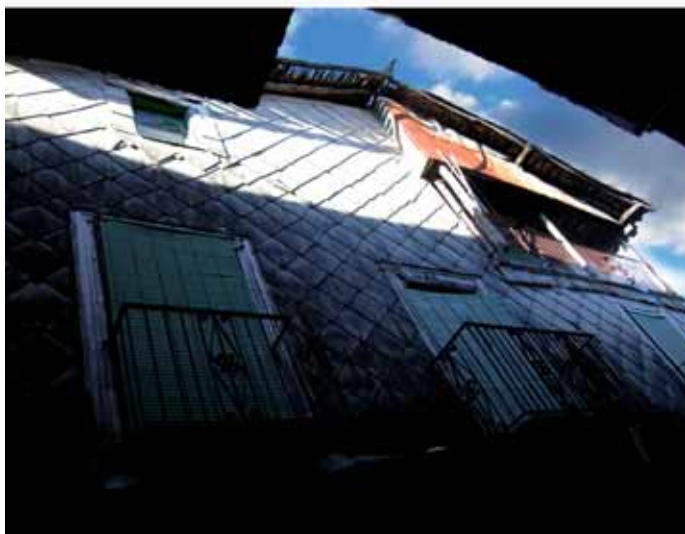
Fachada de una vivienda cubierta con uralita plana colocada en posición romboidal, retirada alrededor de 2005. Calle Derecha, Miranda del Castañar. Fotografía tomada en 1998.
