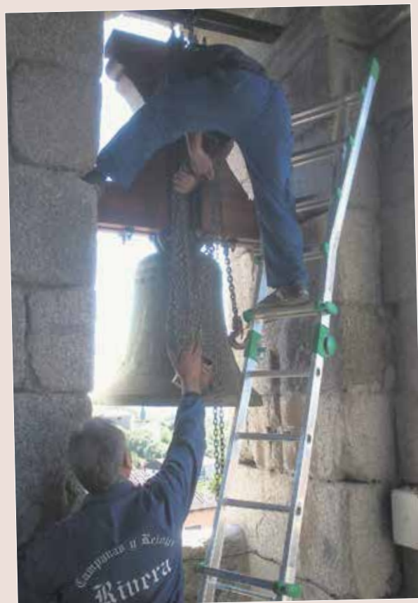
Arreglo de la campana de la torre de la iglesia
