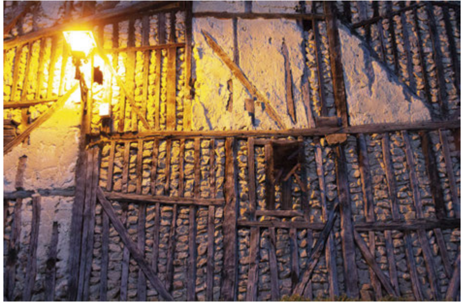
Fachada de tramoneras típica.
